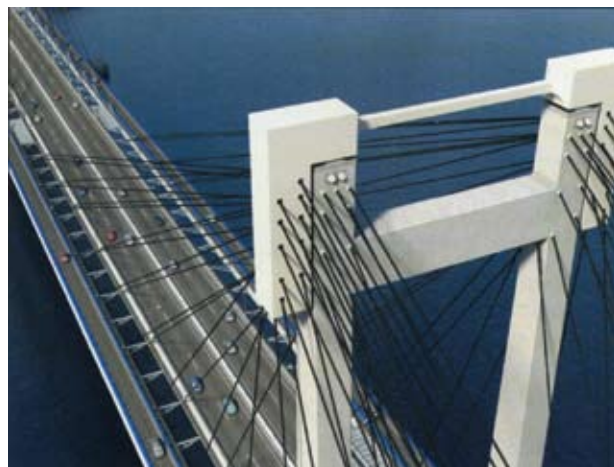
תמונה 8. אלמנט העיגון מפלדה שנבנה על גבי הניצב הישן
