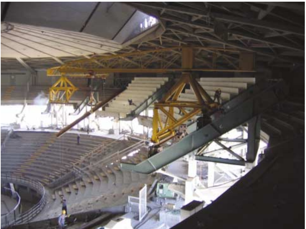
מנופים פנימיים מניחים את רכיבי הטריבונה העליונה החדשה בהיכל הספורט
