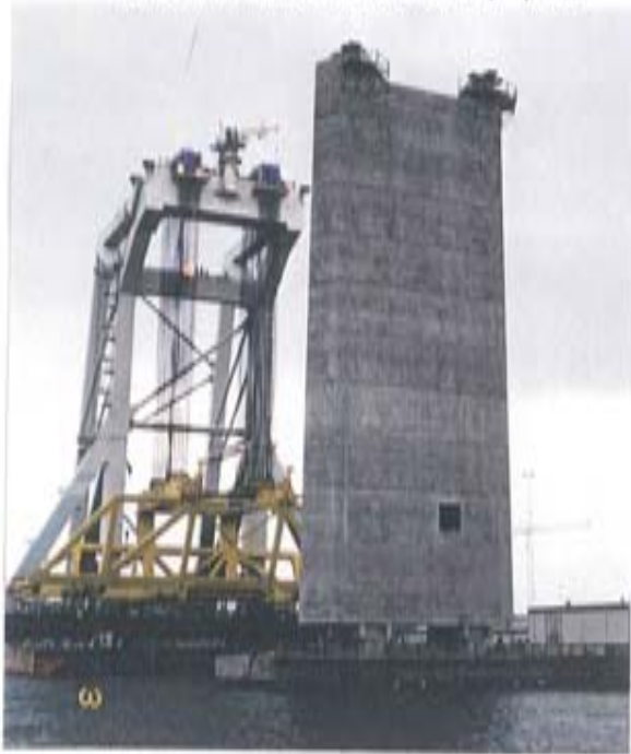
תרשים מס' 13 : עמודי הגשר העשויים מאלמנטי בטון טרומיים בחתך קופסא מוכנים להובלה לאתר.
