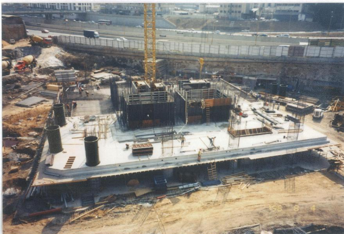
הרכבת תבניות לגרעין המרכזי במגדל המרובע בקומות החניון - אוגוסט 1996
