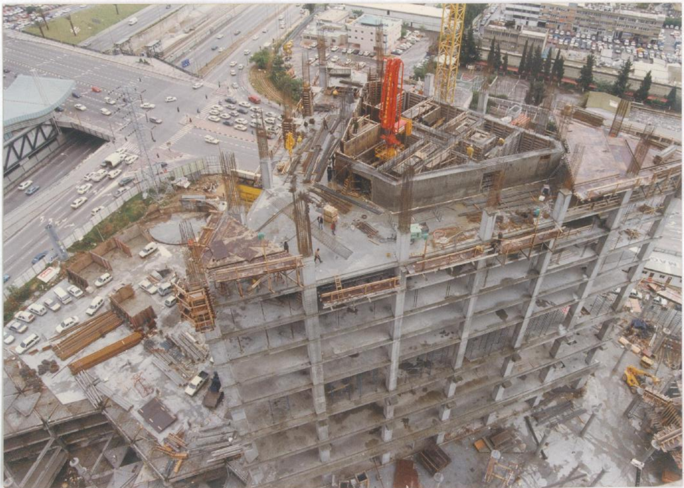
ביצוע הקומה ה- 14 במגדל המשולש - באגף המערבי מבוצעת התקרה
