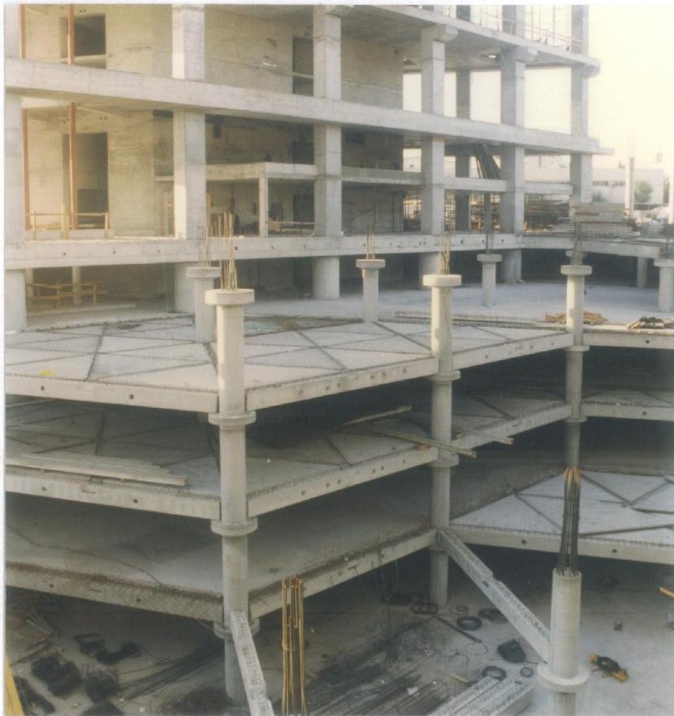
הרכבת קורות ותקררות לגובה 4 קומות החניון - תקרה אחר תקרה
